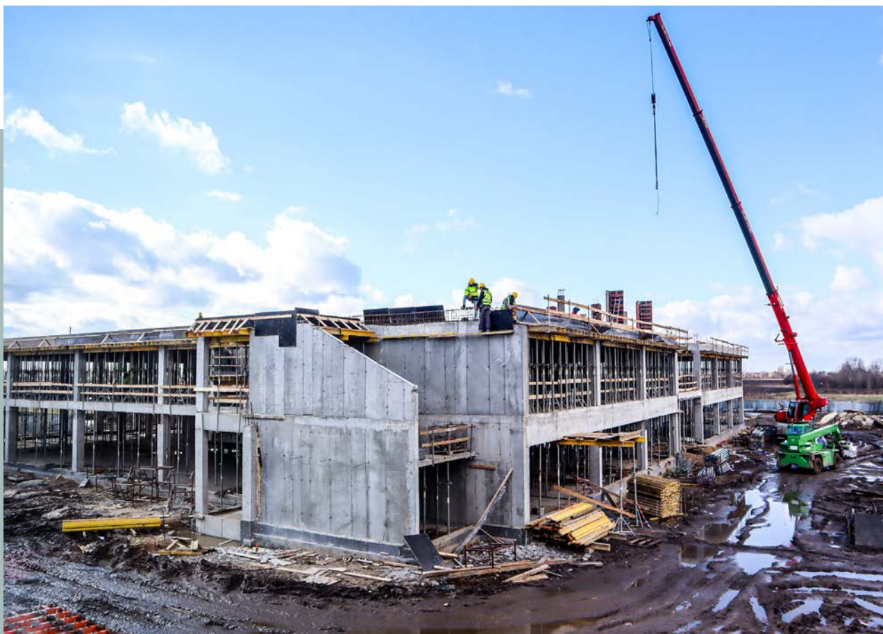
Trwająca rozbudowa szkoły (stan na koniec lutego 2022 r.) fot. Gazeta Babicka
