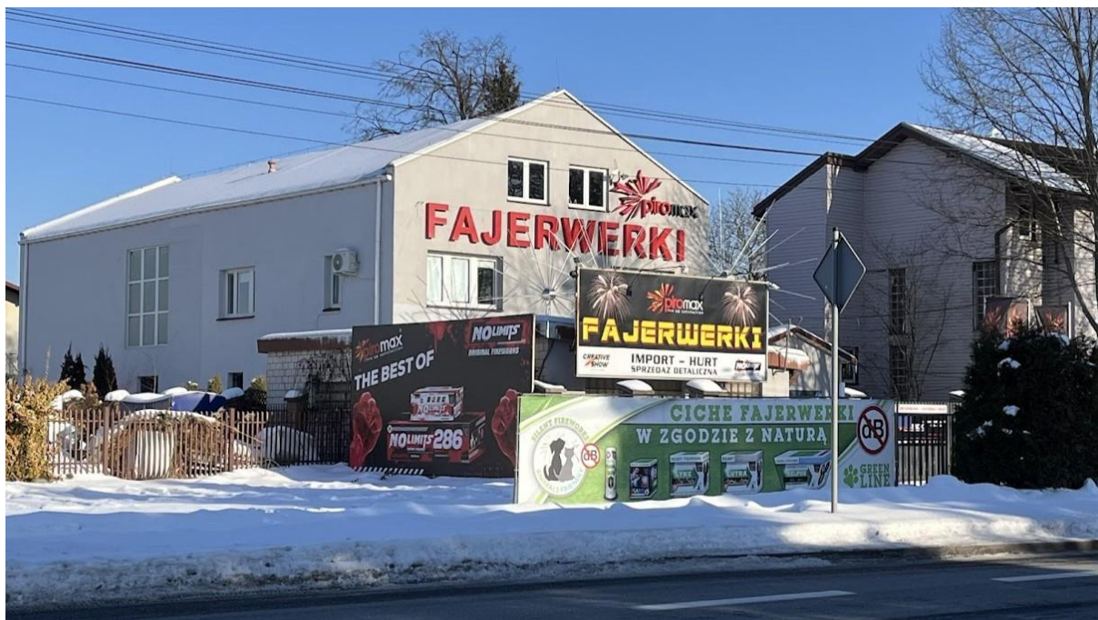
Zdj. 1.6-8 Przykład degradacji
