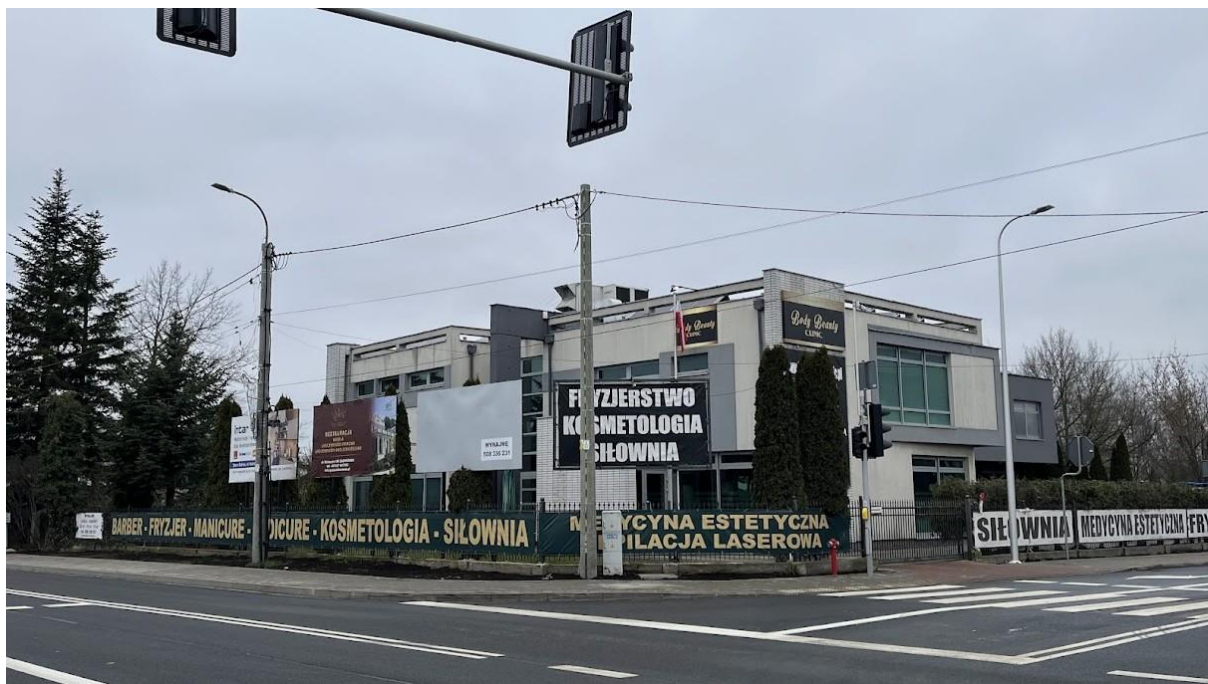
Zdj. 1.6-7 Przykład degradacji
