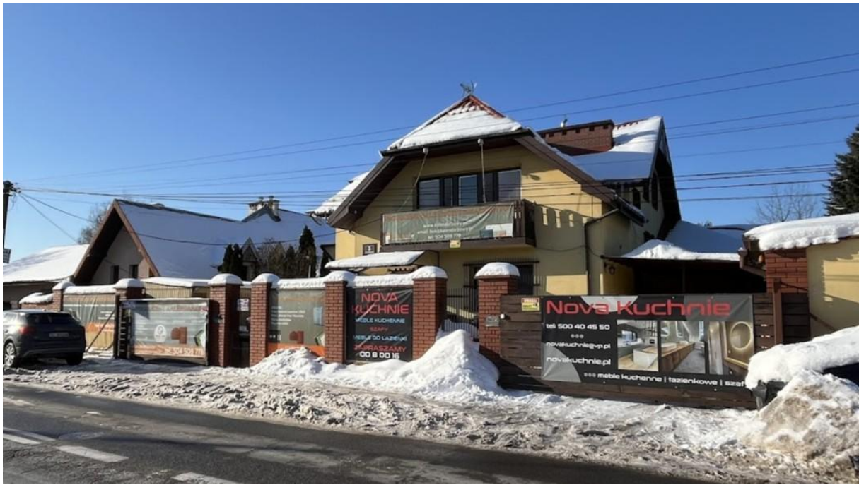
Zdj. 1.6-9 Przykład degradacji
