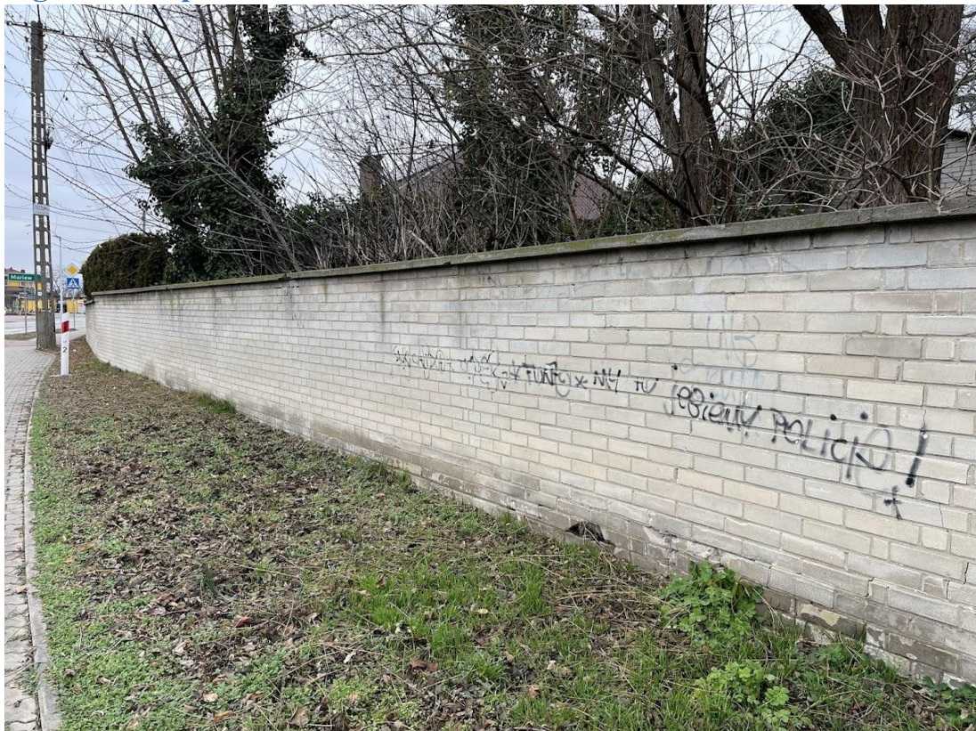
Fot. 2.1-1 Ogrodzenie pełne murowane
