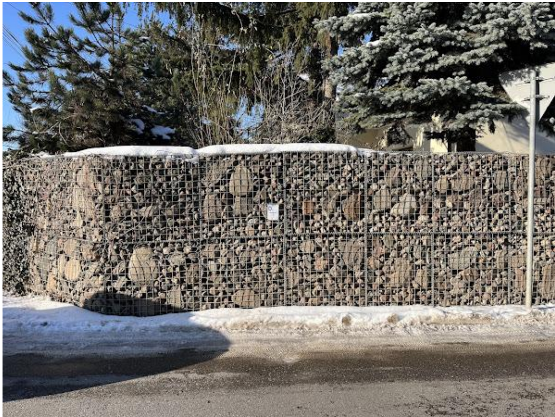
Fot. 2.1-10 Ogrodzenie pelne gabionowe
