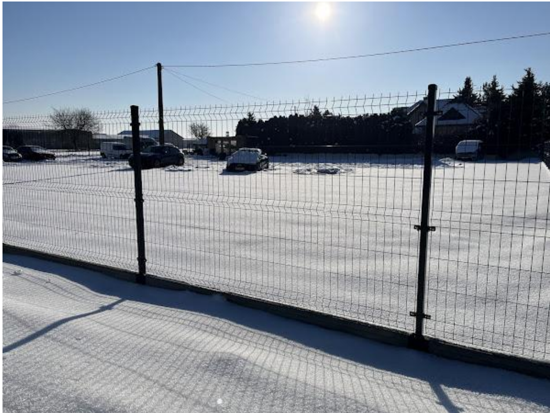
Fot. 2.2-9 Ogrodzenie ażurowe z siatki
