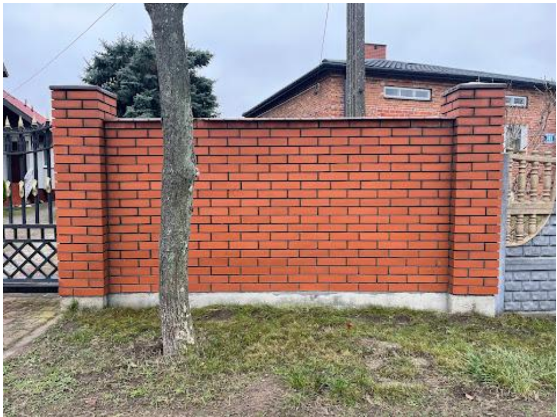
Fot. 2.1-4 Ogrodzenie pełne murowane
