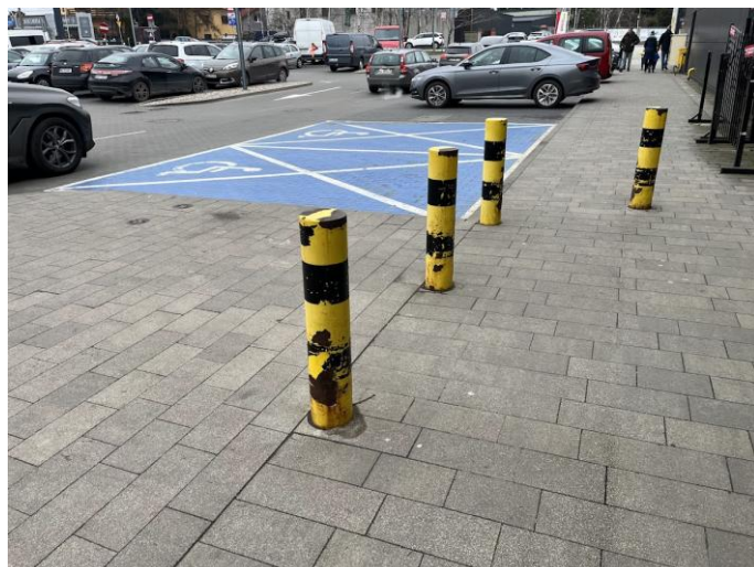
Fot. 3.6-1 Słupki separujące
