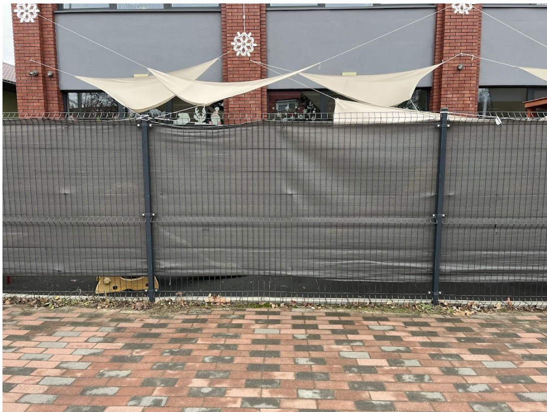
Fot. 2.1-5 Ogrodzenie ażurowe uzupełnione materiałem
