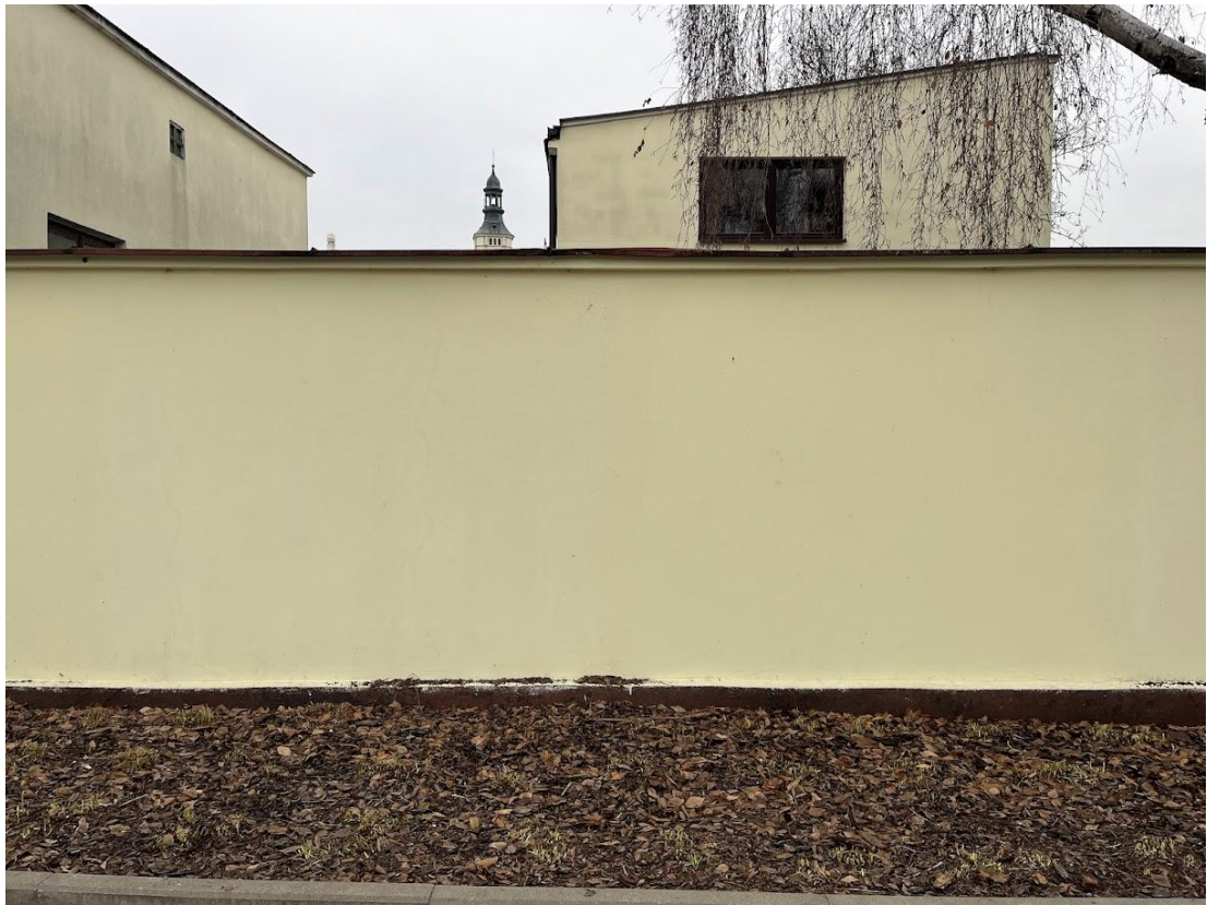
Fot. 2.1-3 Ogrodzenie pełne murowane tynkowane
