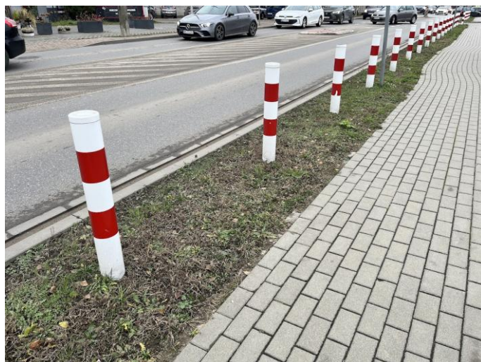
Fot. 3.6-2 Słupki separujące
